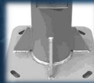
Detalle placa anclaje
